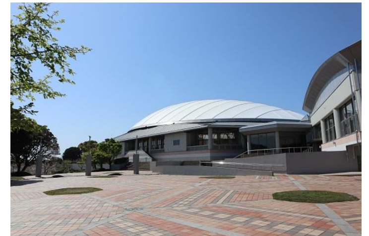
PPP事業で4月に業務受託を開始した粕屋町総合体育館
