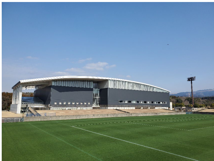
大津町総合体育館
